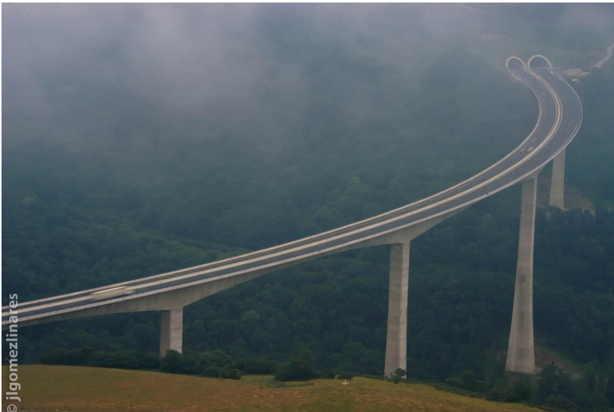
Viaducto de Montabliz (Cantabria)
